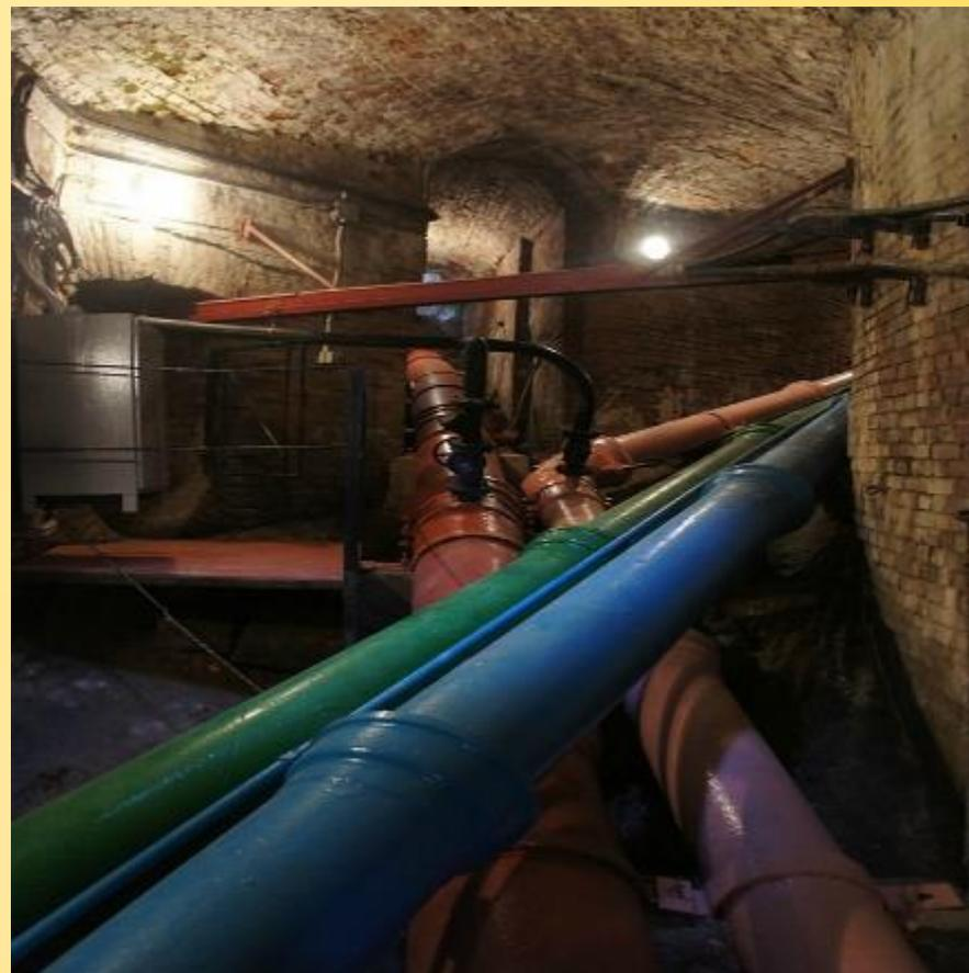
Трубы вначале были деревянными, в 19 веке заменены на металлические. Все виды труб до сих пор используются для обеспечения фонтанов водой, причём больше всего труб именно 19 века. В трубах и кроется секрет петергофских фонтанов - они берут воду из родников возвышенности за 20 км от дворца, и вода попадает в фонтаны под напором благодаря перепаду высот. Поэтому фонтаны и работают ежедневно.
